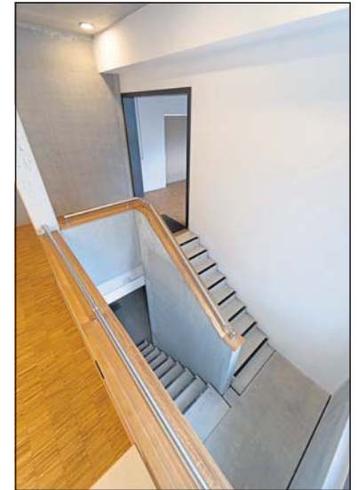
Foto: Bauunternehmen Hill)
