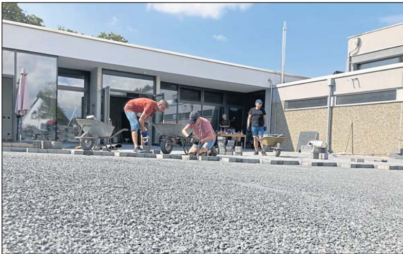
Der bereits verlegte Schotter.
