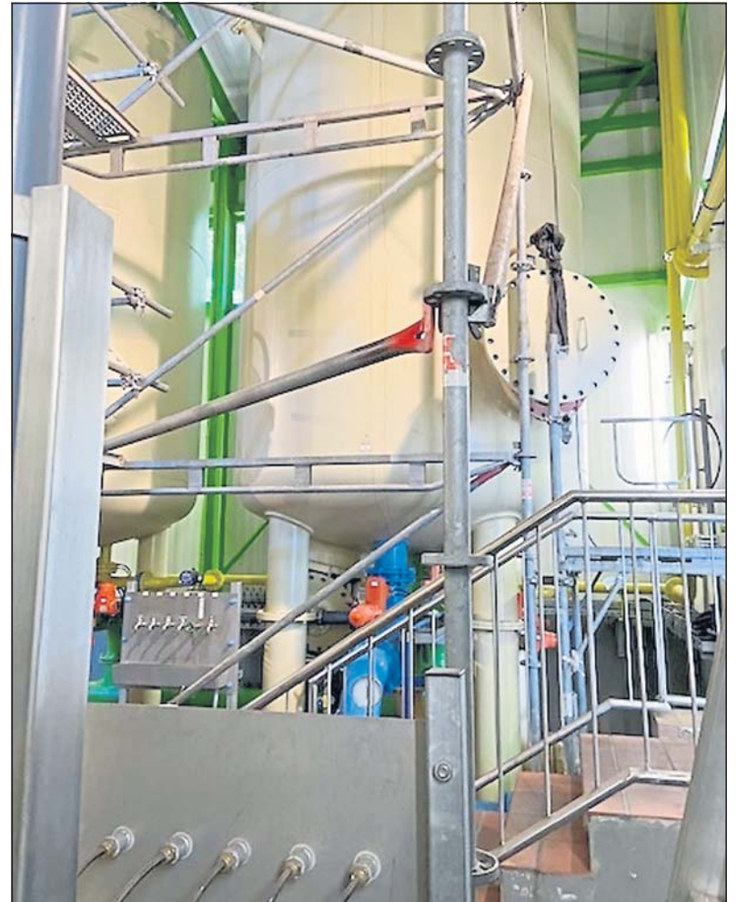
Die Filteranlage im Umbau.
