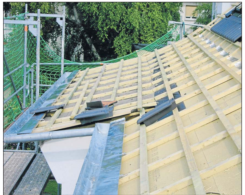
Holzweichfaserplatten sind eine empfehlenswerte Alternative zur Unterspannbahn: Sie sind stabiler und bieten einen zusätzlichen Dämmeffekt. (Foto: VZ RLP)
