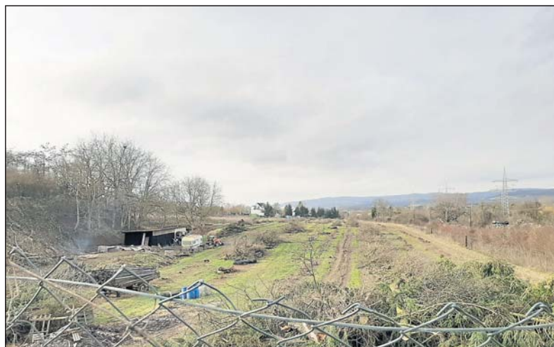
Der Blick auf die ehemalige Obstplantage und den künftigen Brückenstandort nach den Rodungsmaßnahmen. (Fotos: Gemeinde Budenheim)
