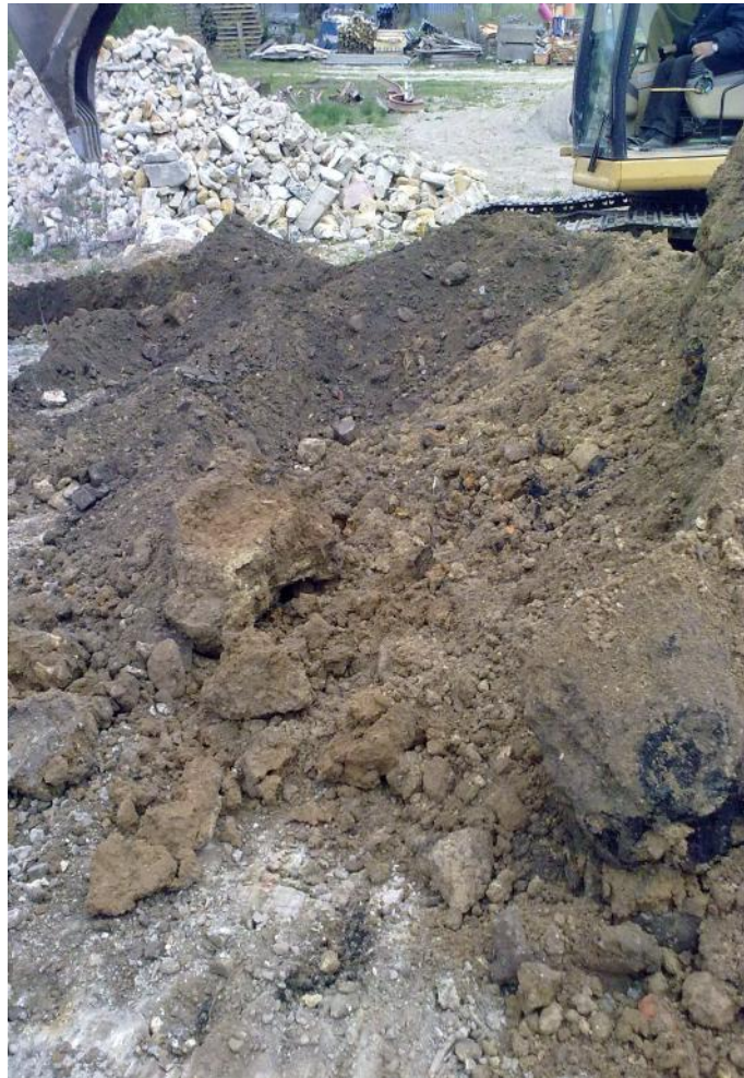
Bild 7: Bodenverhältnisse in Schurf 4 (Detail Haufwerk)
