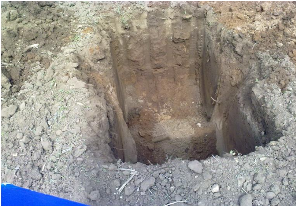
Bild 12: Bodenverhältnisse in Schurf 8
