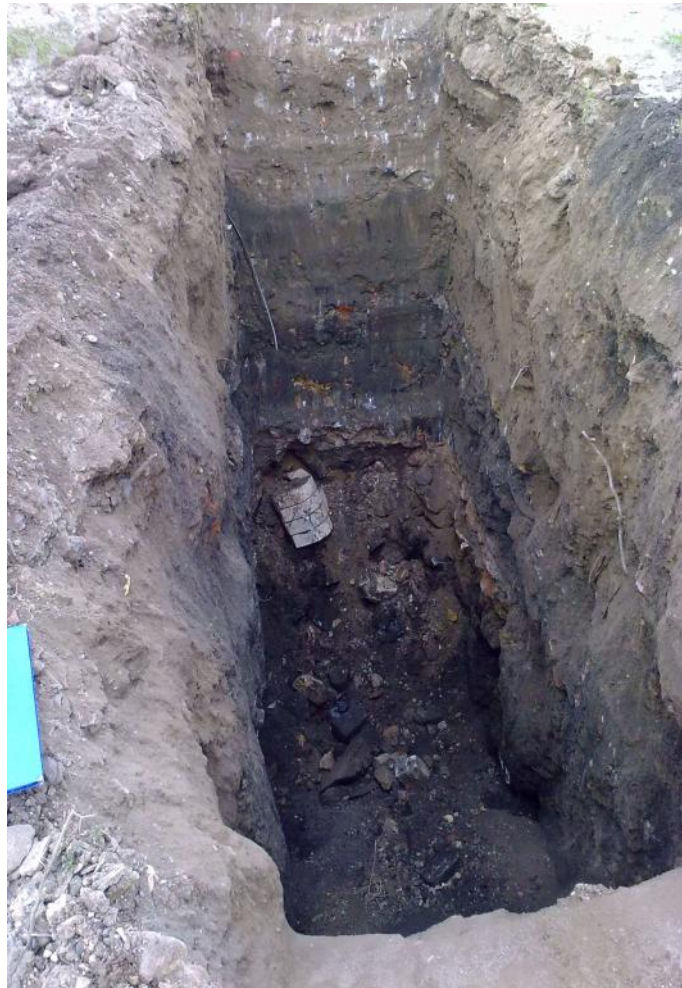
Bild 3: Bodenverhältnisse in Schurf 3
