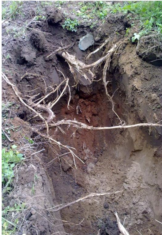
Bild 10: Bodenverhältnisse in Schurf 6
