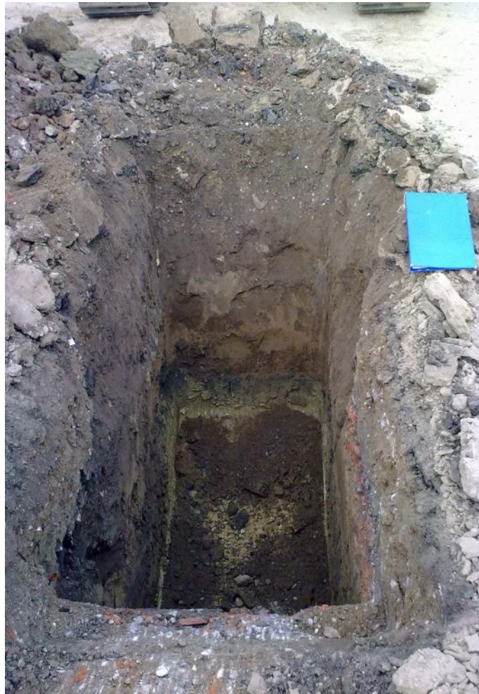
Bild 2: Bodenverhältnisse in Schurf 2
